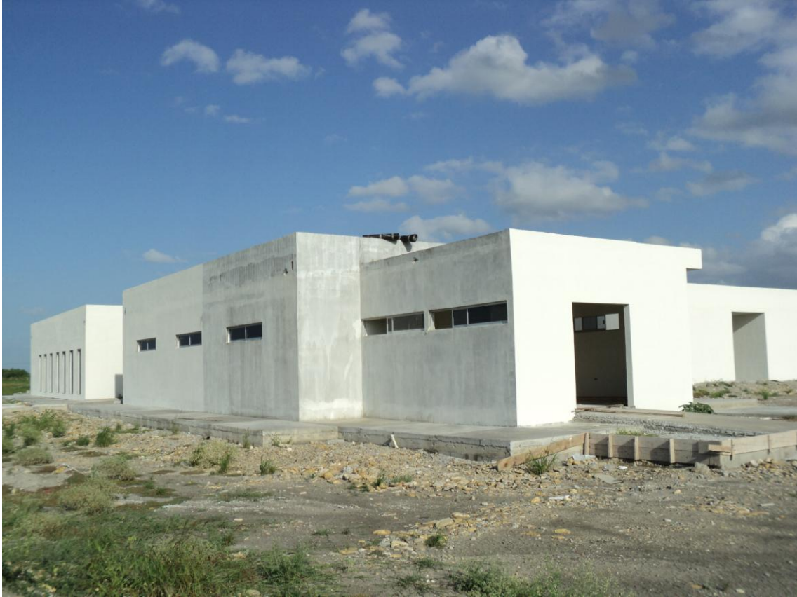
Edificio en construcción de la Unidad Académica de Educación a Distancia, en Abasolo Tamaulipas
